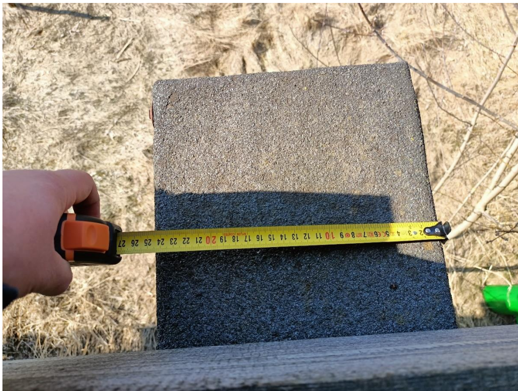
Fot. 25. – Pomiar drewnianej belki poprzecznej pomostu
