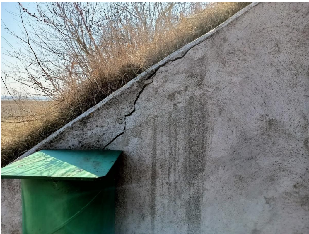
Fot. 50. – Widok na skrzydło wschodnie przy przyczółku nr 2 – uszkodzenie betonu skrzydła
