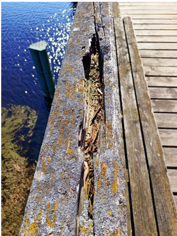
Fot. 61. – Ubytki w drewnianych elementach balustrad; narośla organiczne na drewnianych elementach balustrad i pomostu
