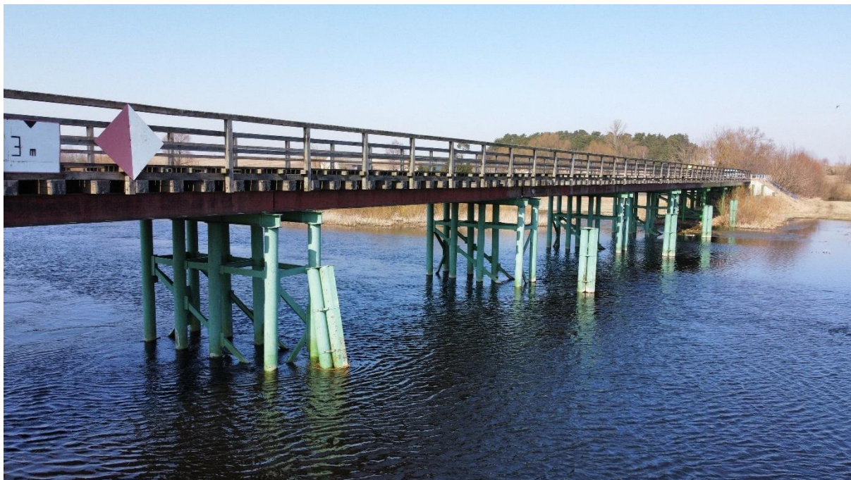
Fot. 31. – Widok od strony górnej wody - pochylona izbica przy filarze nr 7 oraz brak powłok antykorozyjnych na elementach stalowych pomostu
