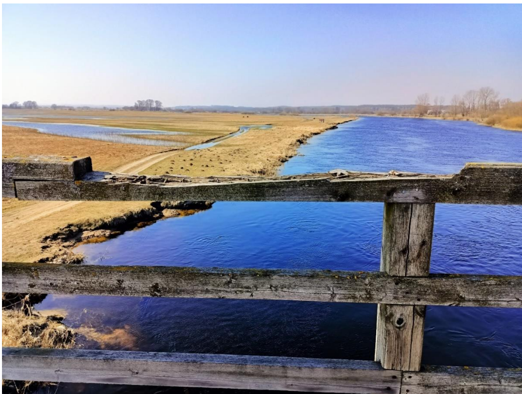
Fot. 74. – Ubytki w drewnianych elementach balustrad; narośla organiczne na drewnianych elementach balustrad i pomostu
