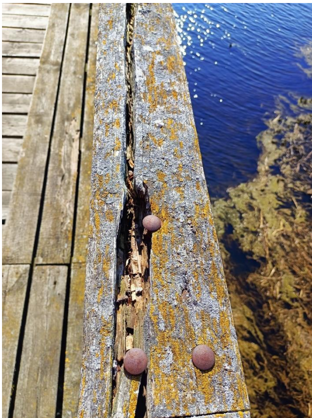
Fot. 57. – Korozja stalowych elementów połączeń drewnianej konstrukcji pomostu; ubytki w drewnianych elementach poszycia pomostu; narośla organiczne na drewnianych elementach pomostu
