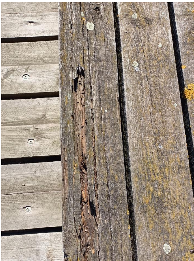
Fot. 68. – Ubytki w drewnianych elementach poszycia pomostu
