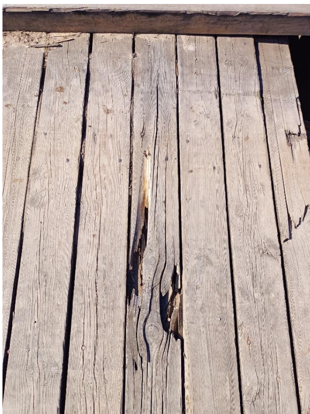
Fot. 66. – Ubytki w drewnianych elementach poszycia pomostu
