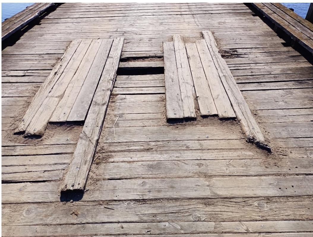
Fot. 54. – Ubytki w drewnianych elementach poszycia pomostu
