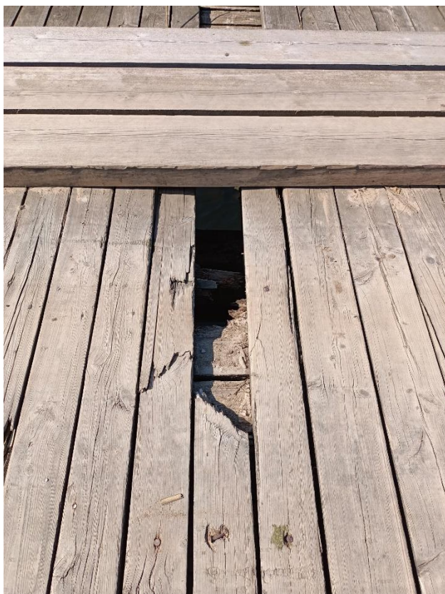
Fot. 64. – Ubytki w drewnianych elementach poszycia pomostu
