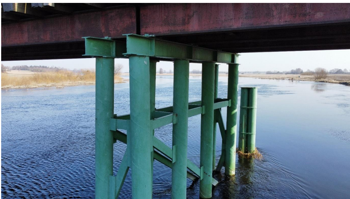
Fot. 34. – Widok od strony dolnej wody - brak powłok antykorozyjnych na elementach stalowych pomostu – występowanie ognisk korozji – odcinek od przęsła nr 4 do przęsła nr 9
