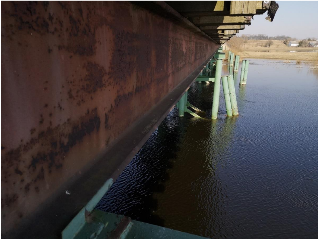
Fot. 39. – Widok od strony górnej wody - pochylona izbica przy filarze nr 7 oraz brak powłok antykorozyyjnych na elementach stalowych pomostu
