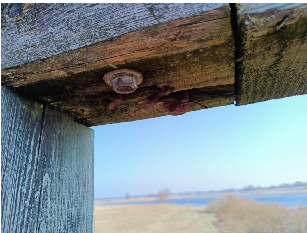
Fot. 52. – Korozja stalowych elementów połączeń drewnianej konstrukcji pomostu
