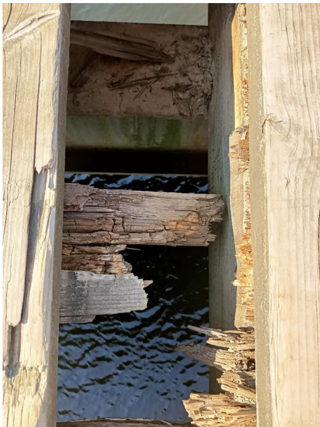
Fot. 65. – Ubytki w drewnianych elementach poszycia pomostu
