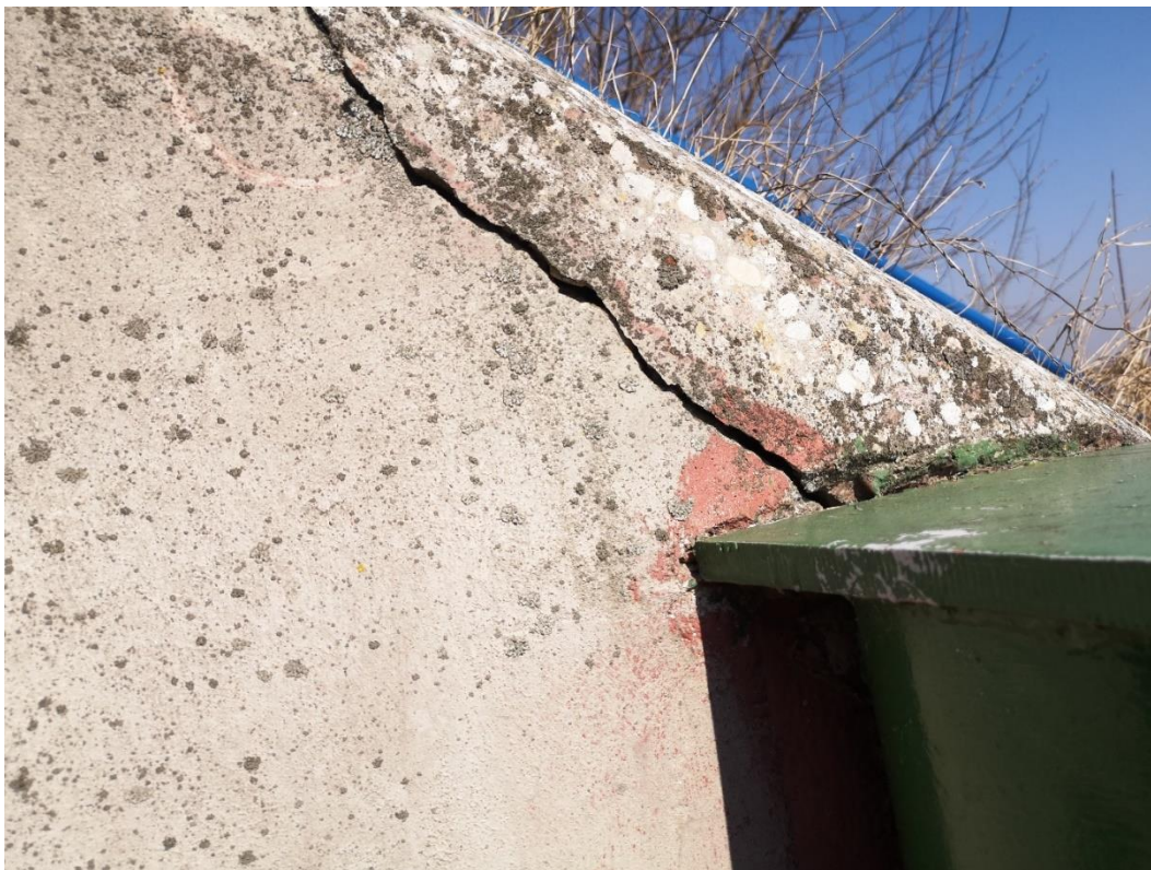
Fot. 41. – Widok na skrzydło wschodnie przy przyczółku nr 1 – uszkodzenie betonu skrzydła
