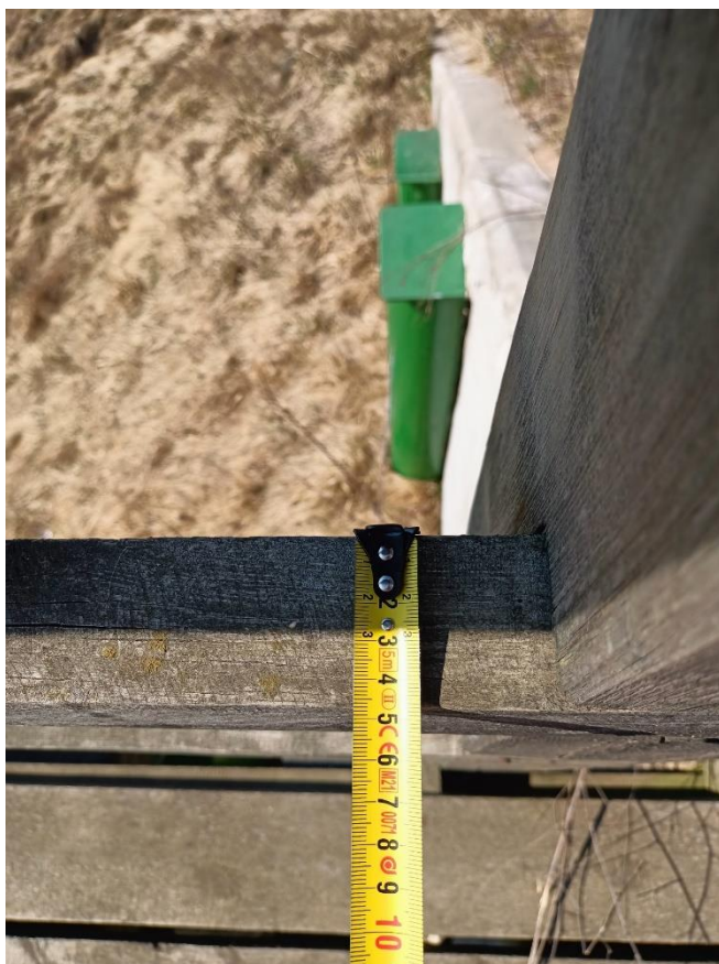
Fot. 20. – Pomiar elementów balustrady drewnianej
