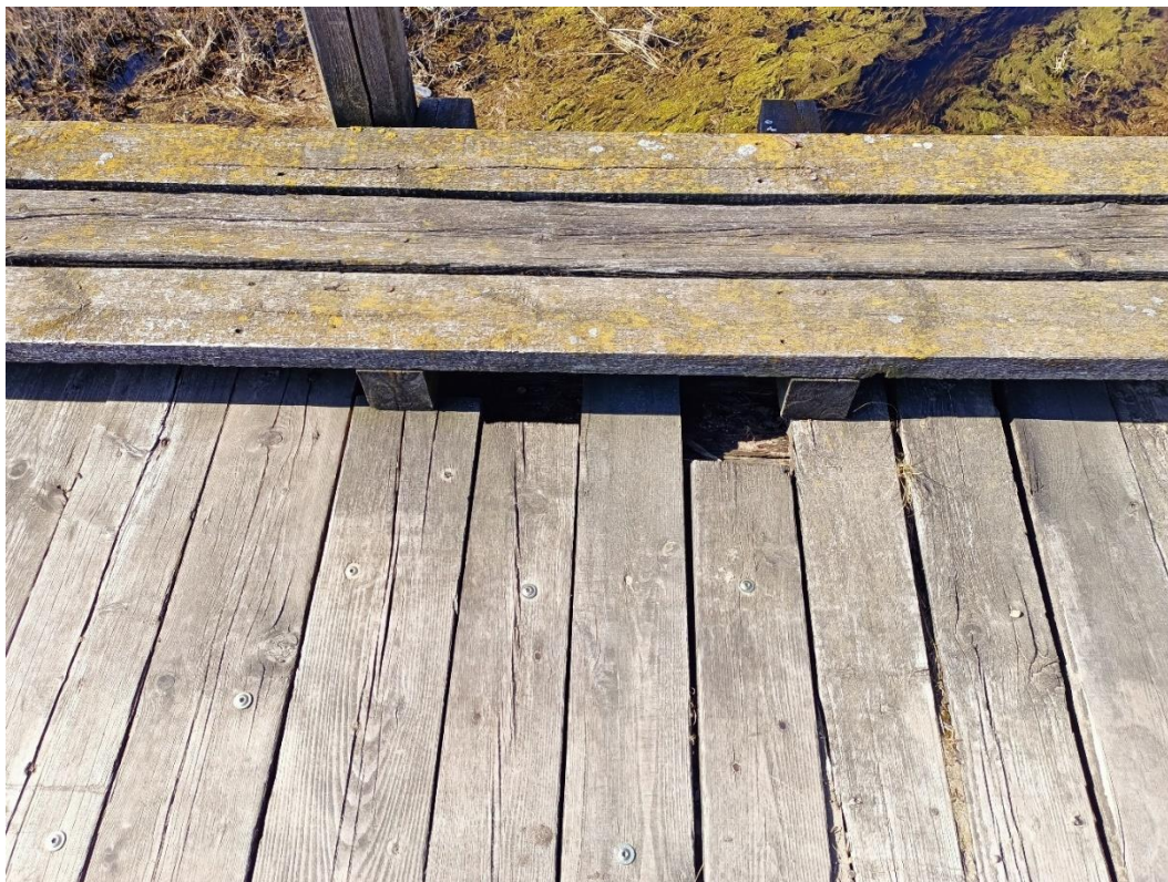
Fot. 55. – Narośla organiczne na drewnianych elementach pomostu; ubytki w drewnianych elementach poszycia pomostu
