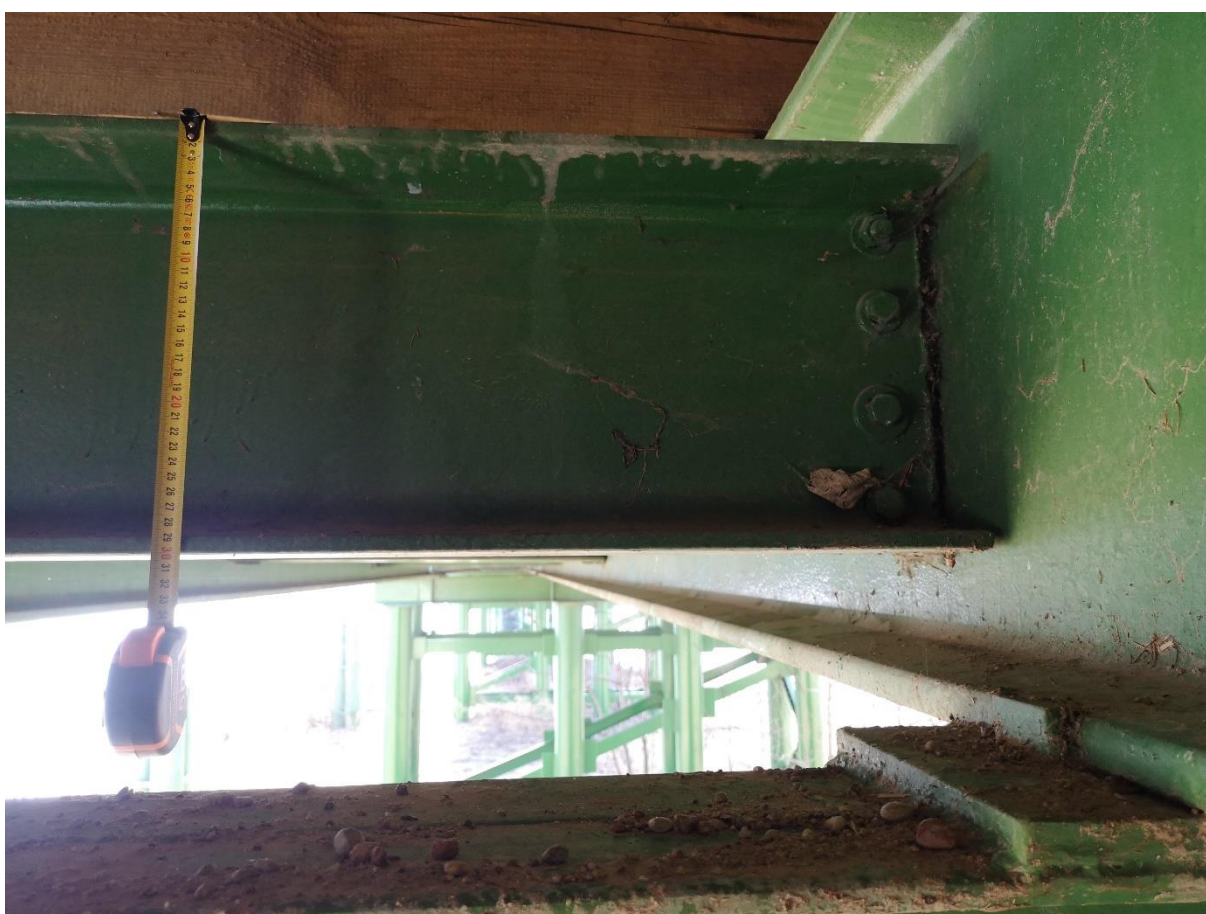
Fot. 16. – Pomiar geometrii poprzecznic pomostu
