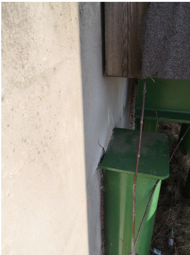
Fot. 45. – Widok na korpusz przyczółka nr 1 – uszkodzenie betonu przyczółka
