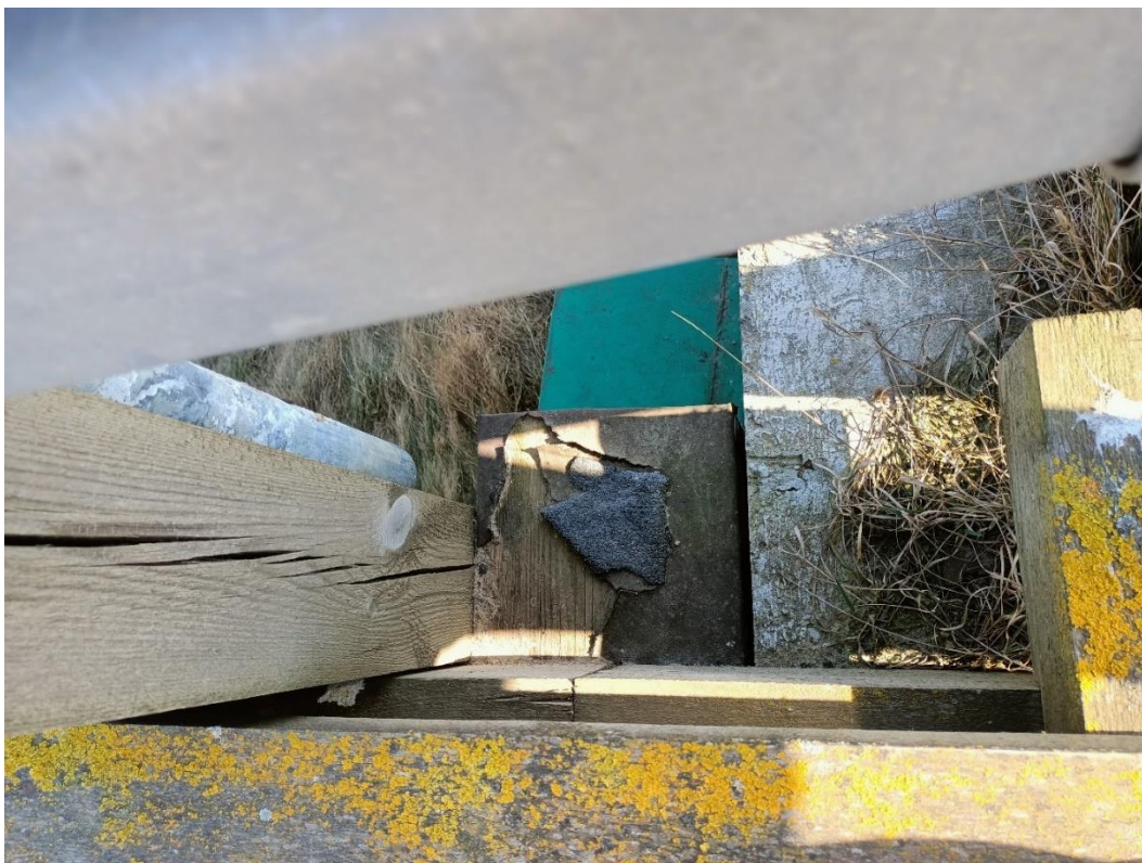
Fot. 76. – Uszkodzenie zabezpieczenia drewnianej belki poprzecznej pomostu przy przyczółku P2; narośla organiczne na drewnianych elementach pomostu
