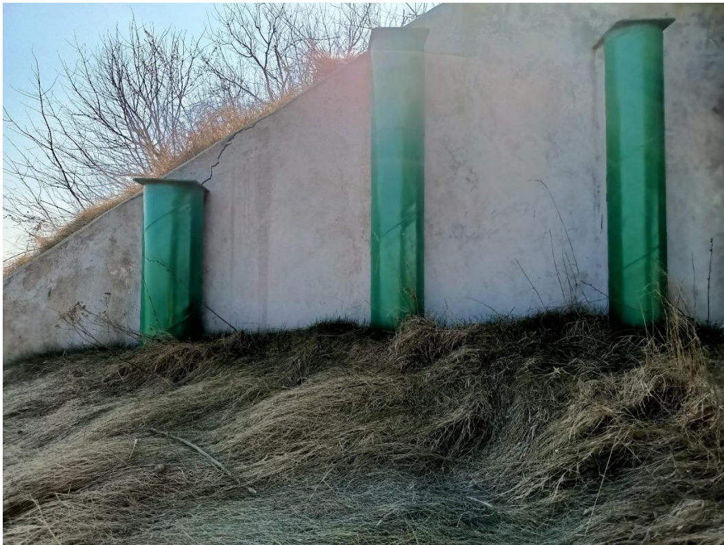
Fot. 49. – Widok na skrzydło wschodnie przy przyczółku nr 2 – uszkodzenie betonu skrzydła
