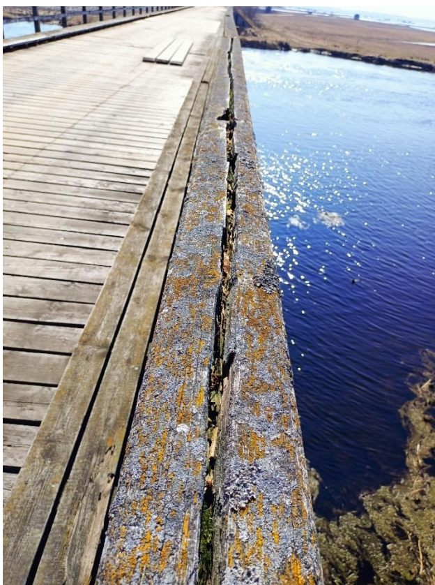
Fot. 58. – Ubytki w drewnianych elementach poszycia pomostu; narośla organiczne na drewnianych elementach pomostu
