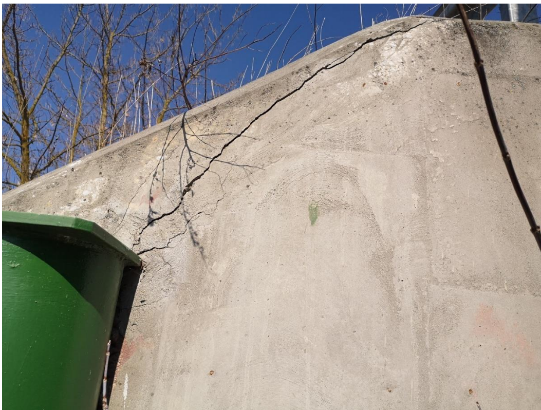
Fot. 42. – Widok na skrzydło zachodnie przy przyczółku nr 1 – uszkodzenie betonu skrzydła
