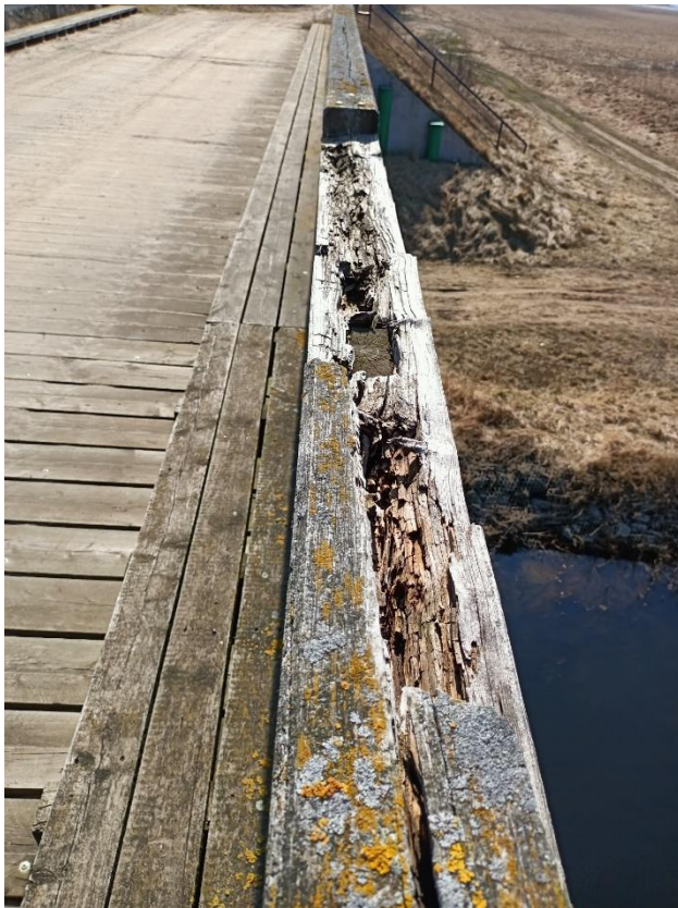
Fot. 73. – Ubytki w drewnianych elementach balustrad; narośla organiczne na drewnianych elementach balustrad i pomostu
