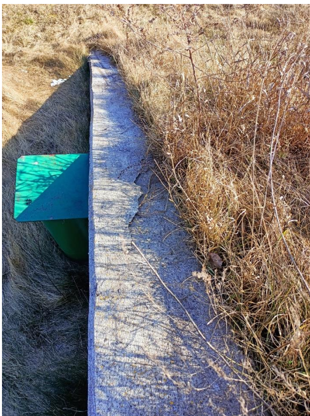
Fot. 48. – Widok z góry na skrzydło wschodnie przy przyczółku nr 2 – uszkodzenie betonu skrzydła; niekontrolowana wegetacja roślinności na skarpie
