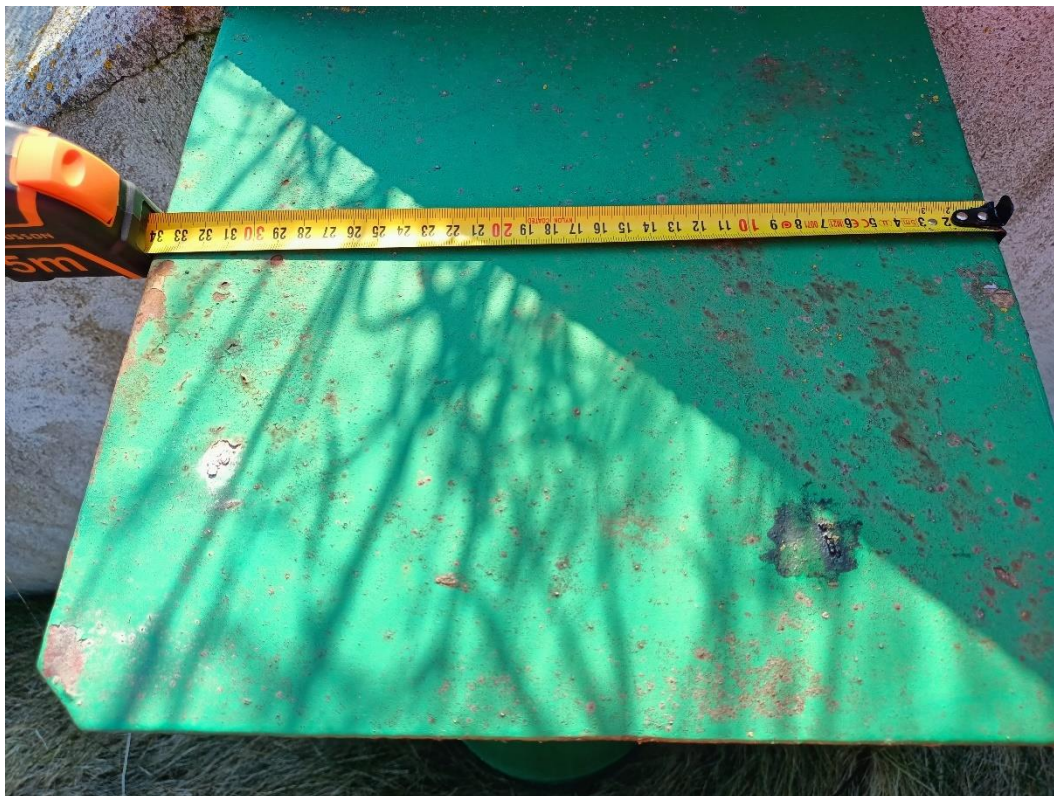
Fot. 23. – Pomiar blachy kryjącej słupopala przy przyczółku
