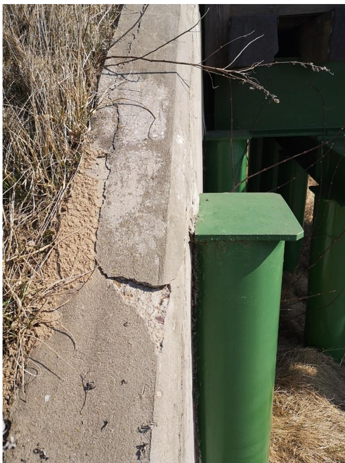
Fot. 44. – Widok z góry na skrzydło zachodnie przy przyczółku nr 1 – uszkodzenie betonu skrzydła
