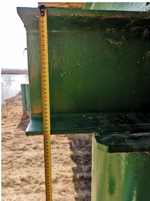
Fot. 14. – Pomiar geometrii belki poprzecznej oczepu filara
