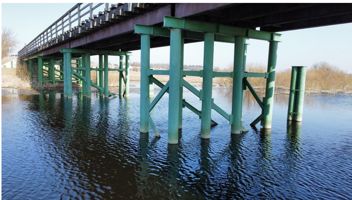
Fot. 32. – Widok od strony dolnej wody - brak powłok antykorozyjnych na elementach stalowych pomostu – występowanie ognisk korozji – odcinek od przęsła nr 4 do przęsła nr 9
