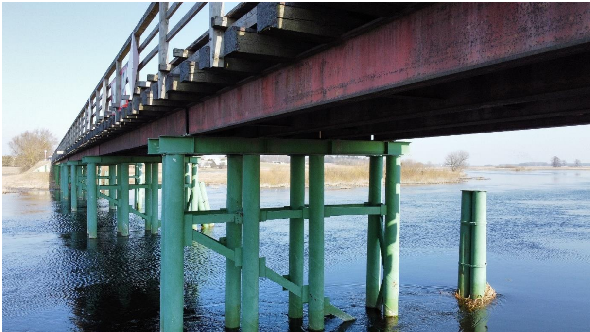
Fot. 35. – Widok od strony dolnej wody - brak powłok antykorozyjnych na elementach stalowych pomostu – występowanie ognisk korozji – odcinek od przęsła nr 4 do przęsła nr 9
