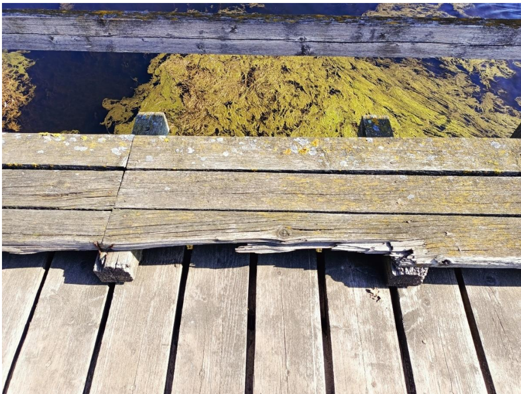
Fot. 59. – Ubytki w drewnianych elementach poszycia pomostu; narośla organiczne na drewnianych elementach pomostu
