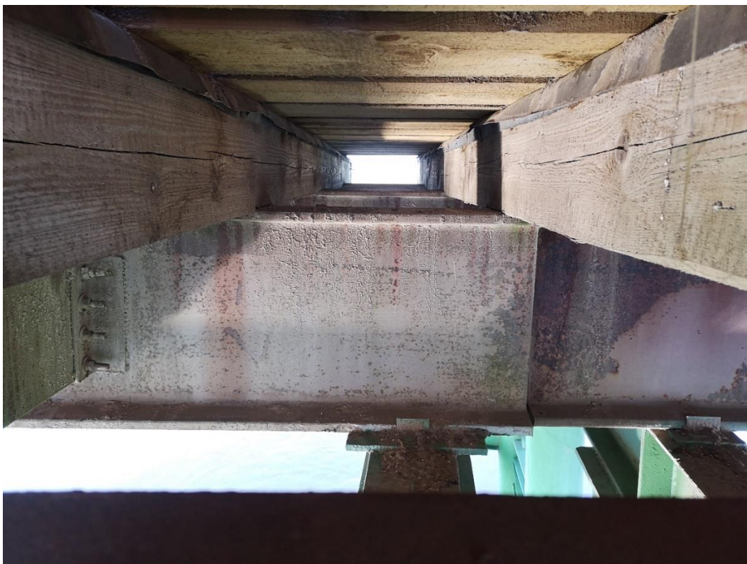
Fot. 38. – Widok konstrukcji pomostu od spodu - brak powłok antykorozyjnych na elementach stalowych pomostu – występowanie ognisk korozji – odcinek od przęsła nr 4 do przęsła nr 9;
