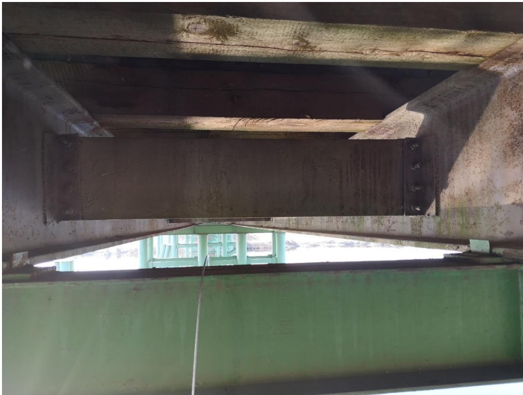
Fot. 37. – Widok konstrukcji pomostu od spodu - brak powłok antykorozyjnych na elementach stalowych pomostu – występowanie ognisk korozji – odcinek od przęsła nr 4 do przęsła nr 9;
