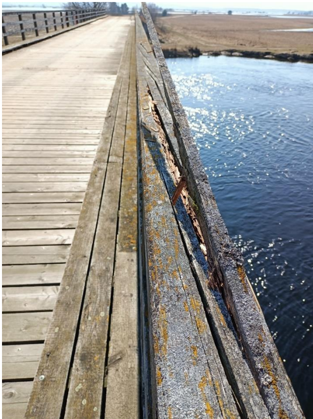
Fot. 67. – Ubytki w drewnianych elementach balustrad; narośla organiczne na drewnianych elementach balustrad i pomostu
