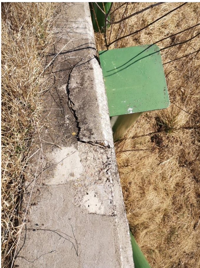
Fot. 40. – Widok z góry na skrzydło wschodnie przy przyczółku nr 1 – uszkodzenie betonu skrzydła
