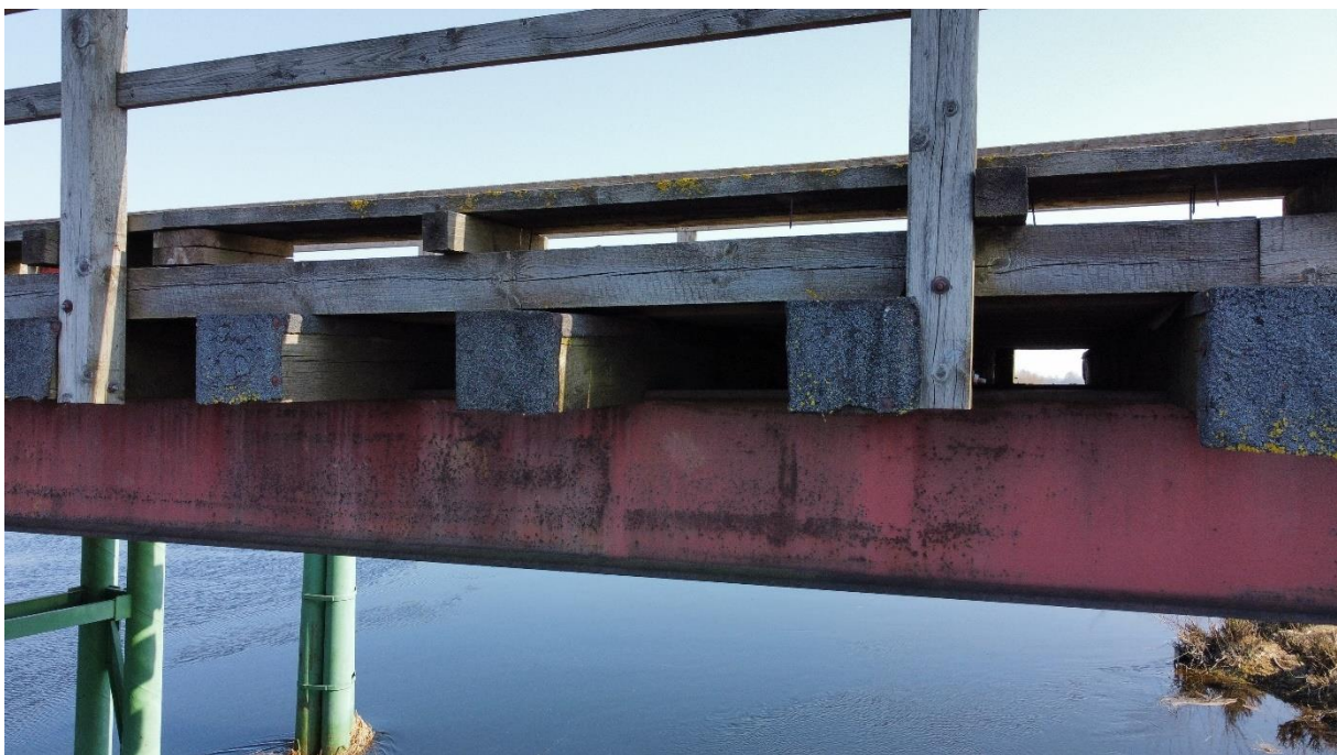
Fot. 36. – Widok od strony dolnej wody - brak powłok antykorozyjnych na elementach stalowych pomostu – występowanie ognisk korozji – odcinek od przęsła nr 4 do przęsła nr 9; narośla organiczne na drewnianej konstrukcji pomostu
