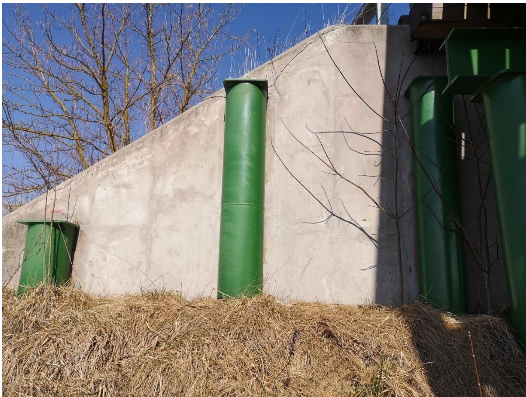
Fot. 43. – Widok na skrzydło zachodnie przy przyczółku nr 1 – uszkodzenie betonu skrzydła
