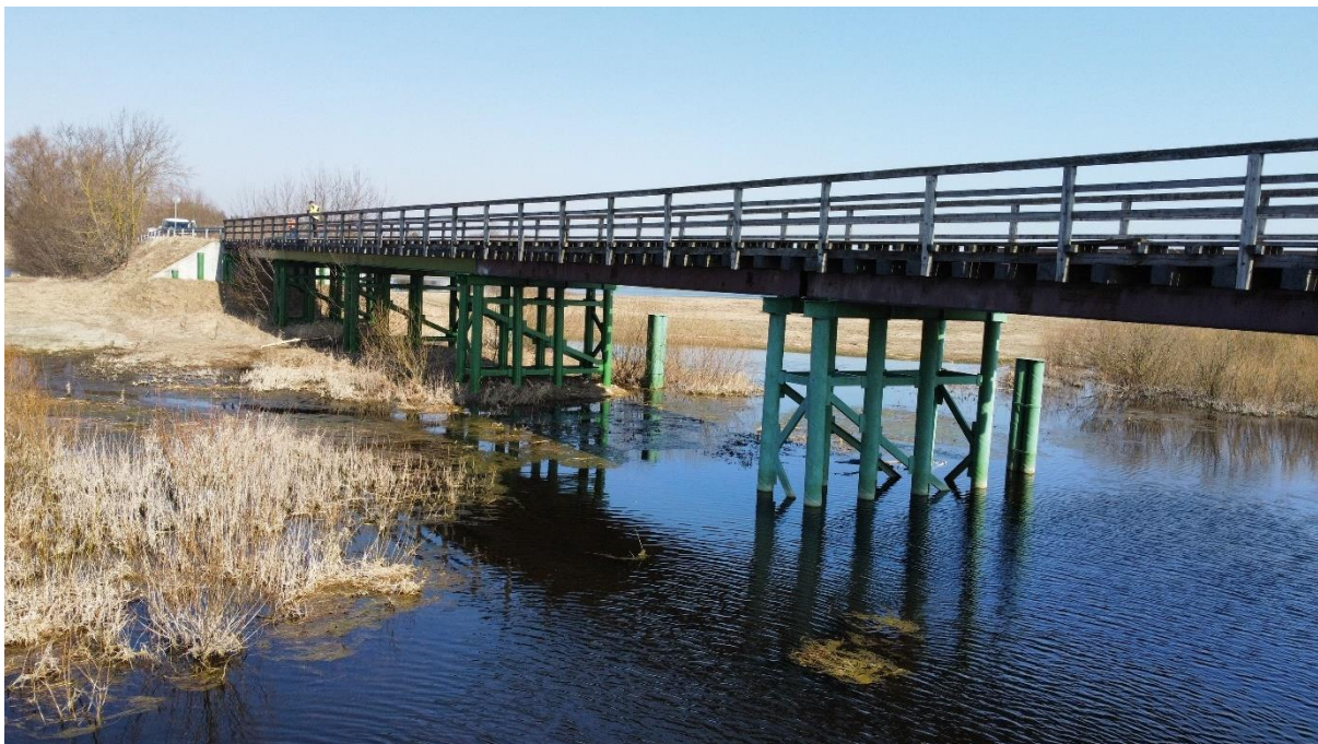
Fot. 33. – Widok od strony dolnej wody - brak powłok antykorozyjnych na elementach stalowych pomostu – występowanie ognisk korozji – odcinek od przęsła nr 4 do przęsła nr 9
