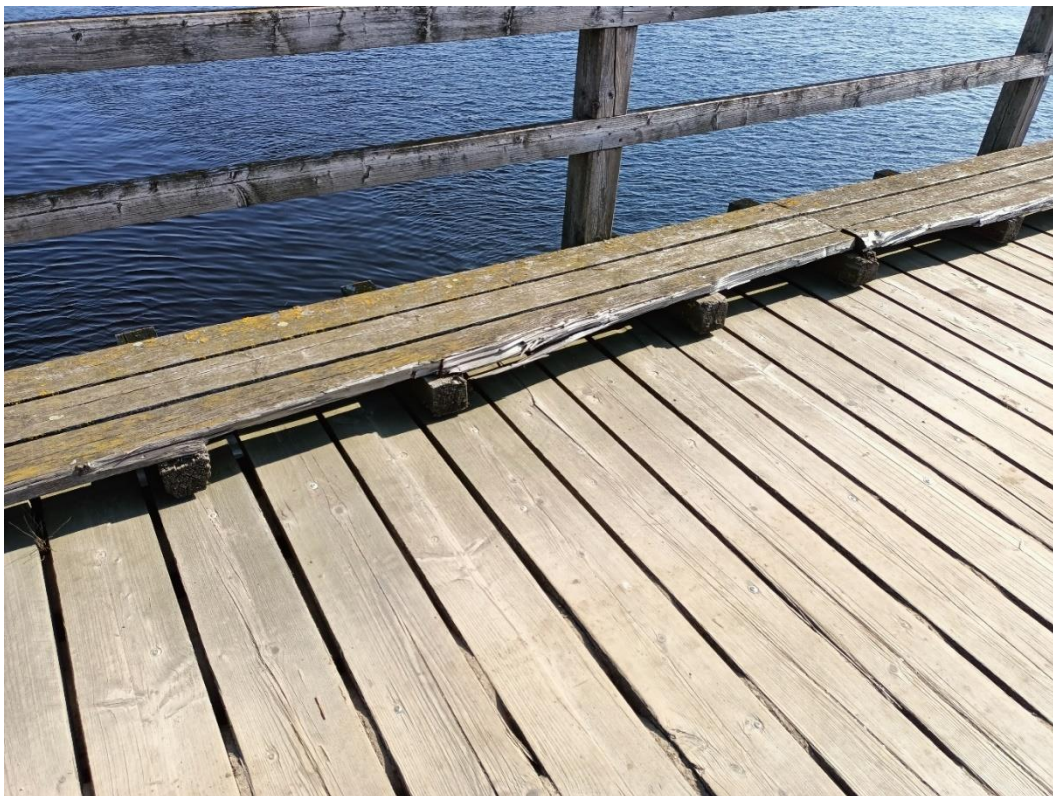
Fot. 69. – Ubytki w drewnianych elementach poszycia chodników
