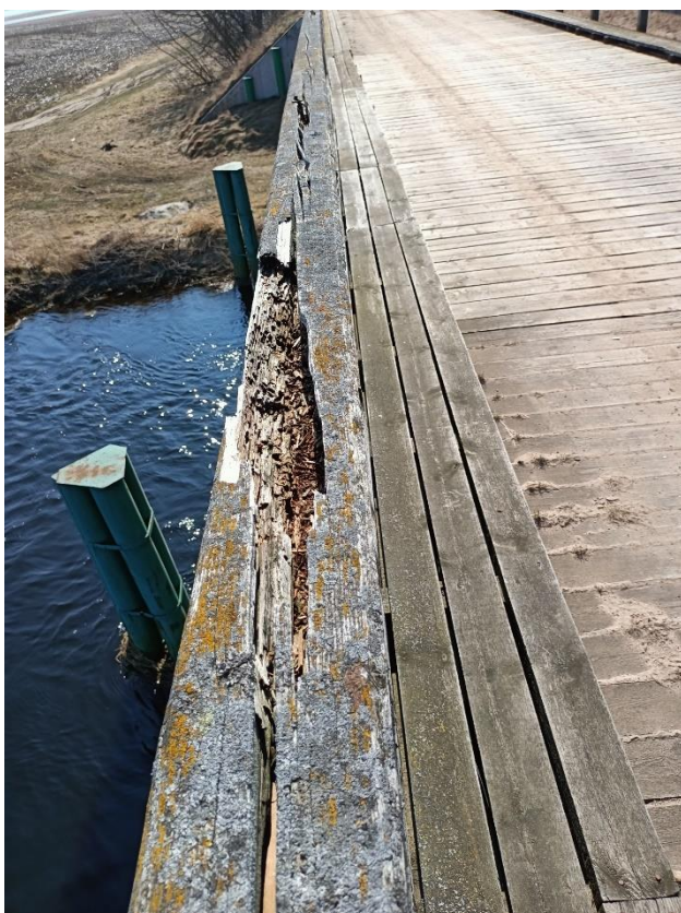
Fot. 72. – Ubytki w drewnianych elementach balustrad; narośla organiczne na drewnianych elementach balustrad i pomostu
