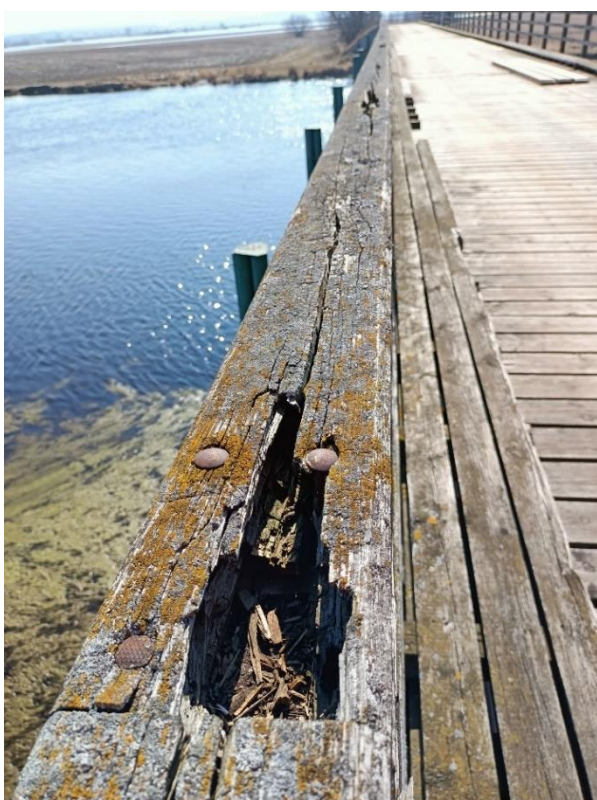
Fot. 60. – Korozja stalowych elementów połączeń drewnianej konstrukcji pomostu; ubytki w drewnianych elementach balustrad; narośla organiczne na drewnianych elementach balustrad i pomostu
