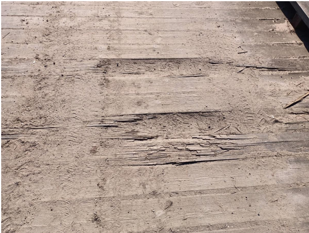
Fot. 75. – Uszkodzenie drewnianych elementów poszycia pomostu
