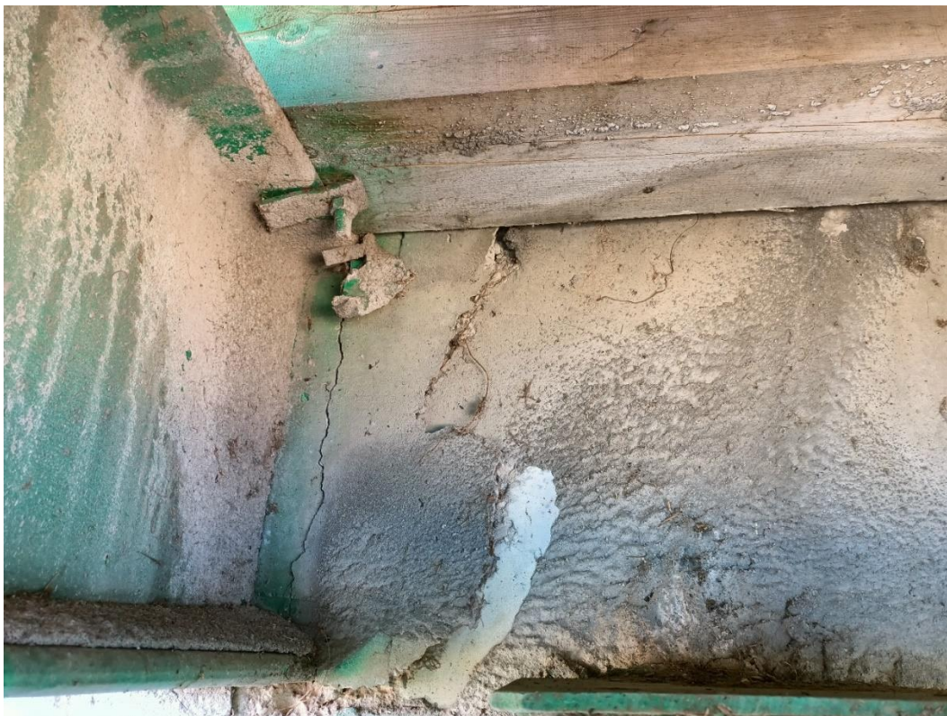
Fot. 51. – Uszkodzenie korpusu przyczółka P2
