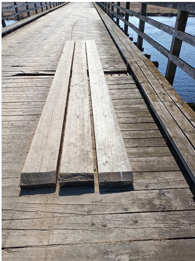
Fot. 63. – Ubytki w drewnianych elementach poszycia pomostu
